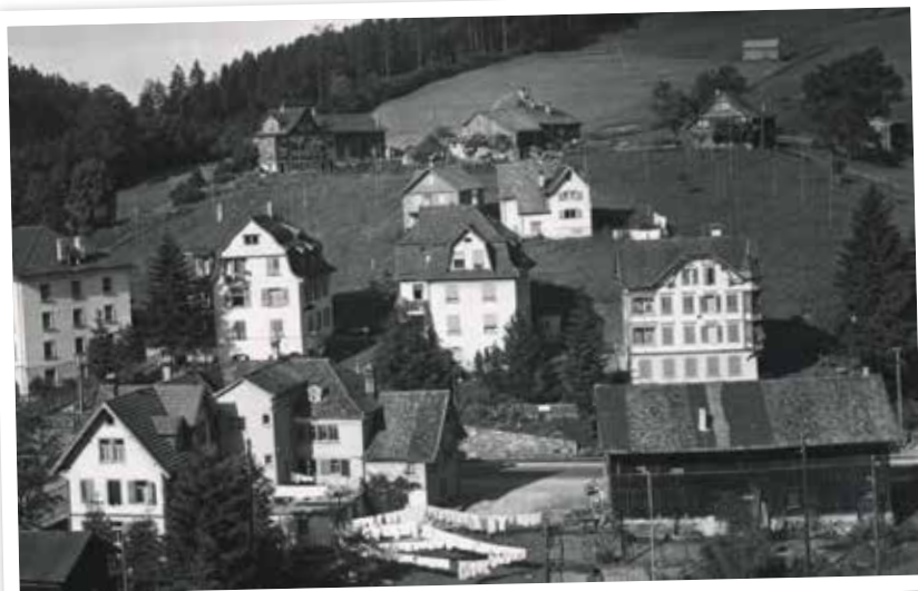
Die alte Wattsiedlung um 1949... Bild: Stadtarchiv
